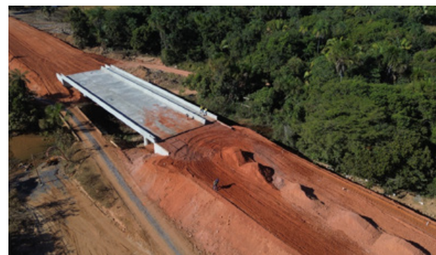
Obras da GO-108 recebem investimento de R$ 140 milhões. Rodovia será a primeira estrada pavimentada dentro de um parque ambiental em Goiás
