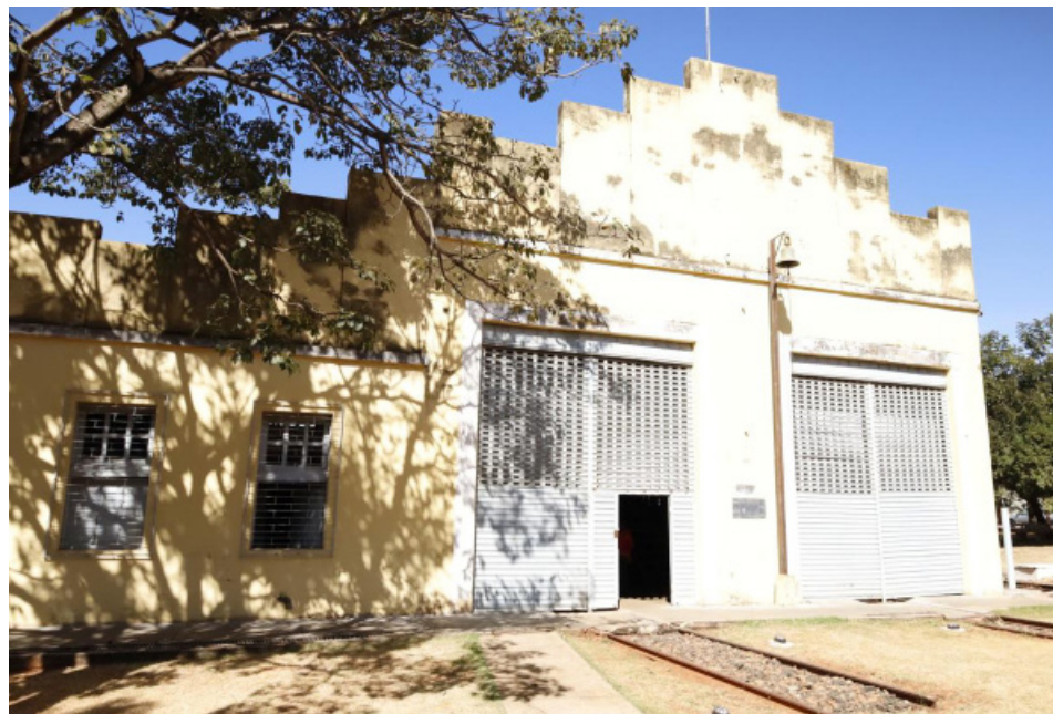
Obras do Museu Ferroviário de Pires do Rio seguem em ritmo acelerado
