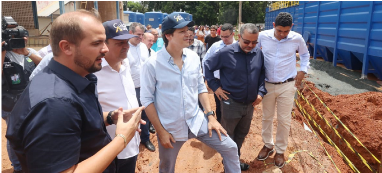
Vice-governador Daniel Vilela visita obras da nova estação de tratamento de água, em Caldas Novas, que vai duplicar abastecimento
