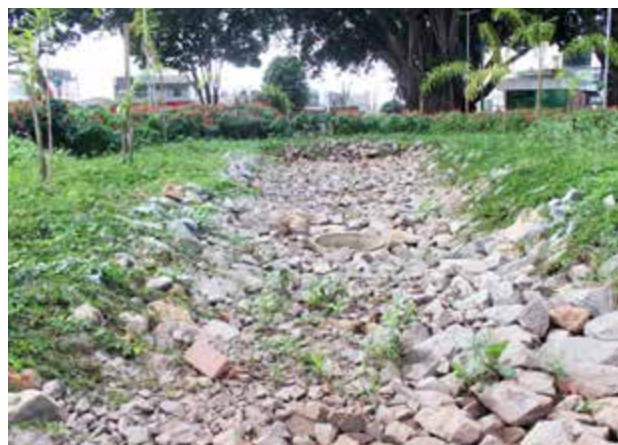
Uma das soluções empregadas para resolver problemas de drenagem urbana na cidade são os jardins de chuva
