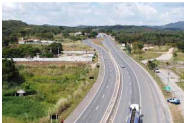
Malha viária no Noroeste de Goiás recebeu mais uma obra de infraestrutura com a duplicação da GO-070
