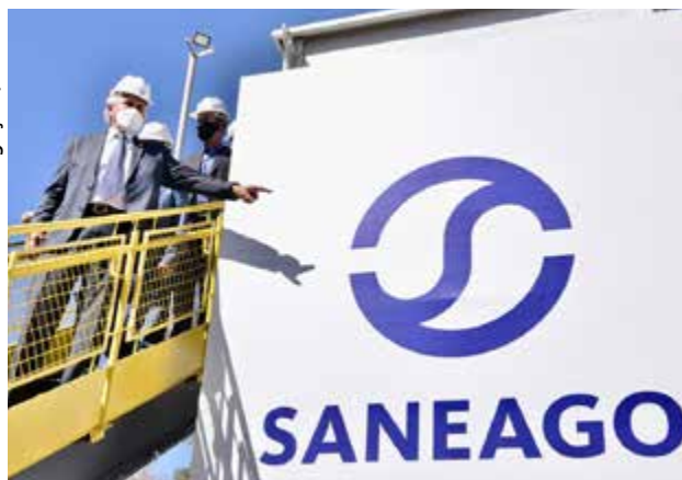
O início das obras ocorreu em fevereiro e a conclusão é prevista para o próximo mês de junho
