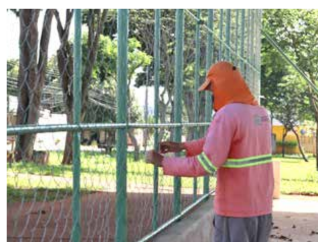
Comurg escalou 50 colaboradores para a revitalização do Complexo Esportivo da Praça 1º de Fevereiro, na Vila Pedroso, com a execução de serviços de pintura, recuperação da pista de skate e ampliação dos vestiários
