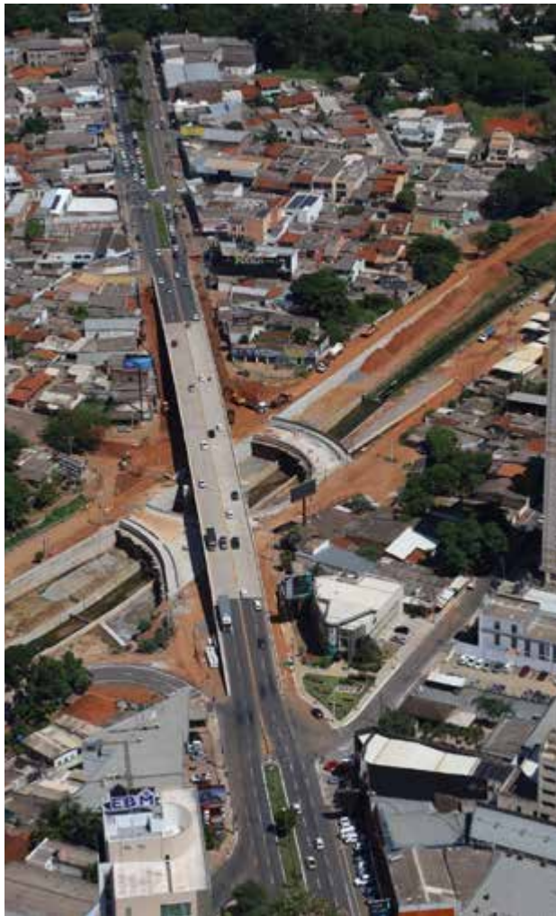
A obra do Complexo Viário Luiz José Costa está com 93% executada e previsão de entrega em dezembro de 2021
