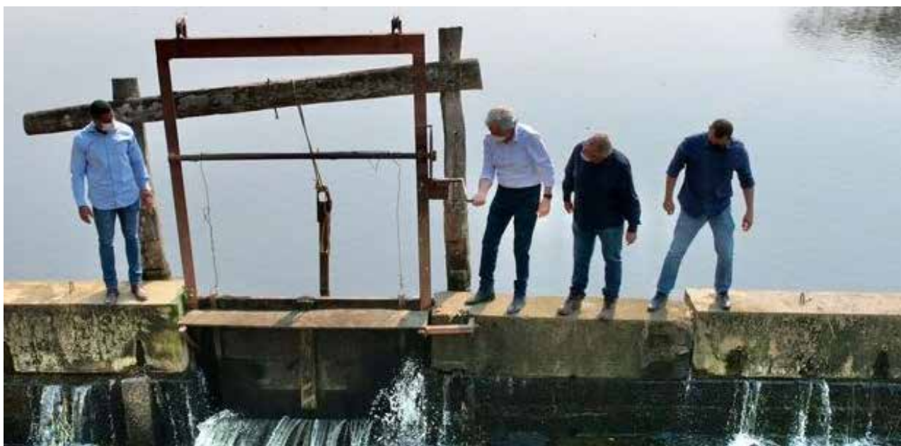
O momento em que governador Ronaldo Caiado abre comporta de barragem na Fazenda Amaralina, zona rural de Goiânia: medida consta em planejamento elaborado pelo Governo de Goiás e reequilibra vazão na Bacia do Rio Meia Ponte
