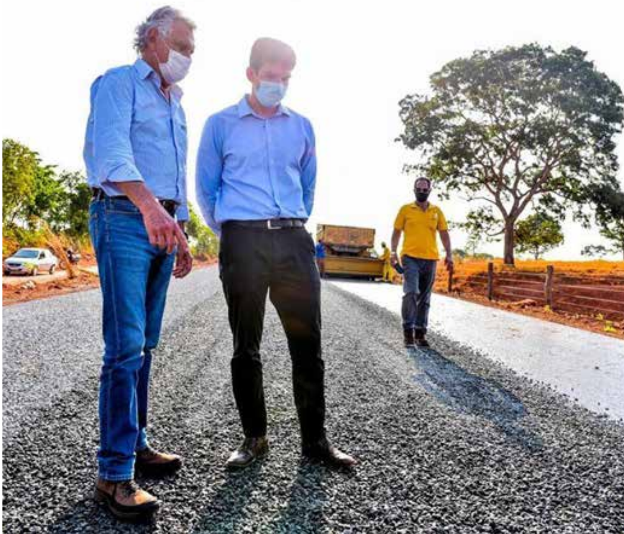
Em Santo Antônio do Descoberto, governador entregou a revitalização de um trecho de 2,8 quilômetros no perímetro urbano da GO-225
